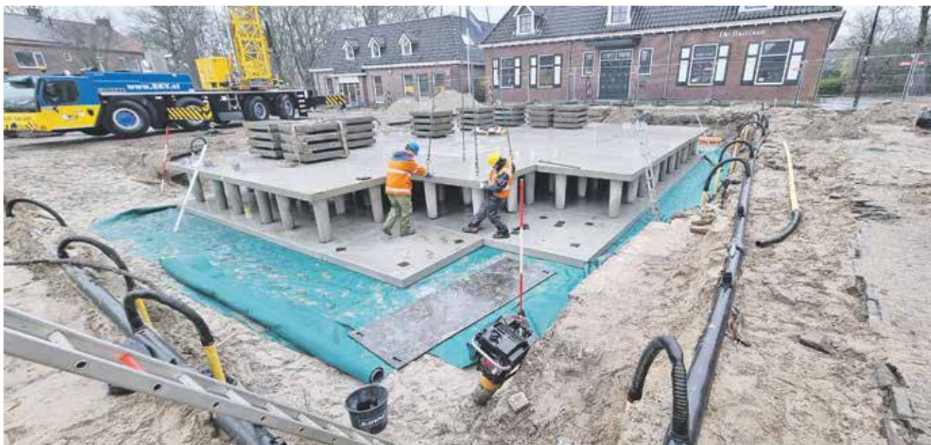
Plaatsen infiltratievoorzieningen Kerkplein Olst
