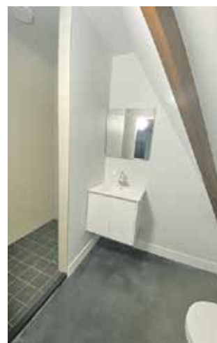
Bovenverdieping na de verbouwing
