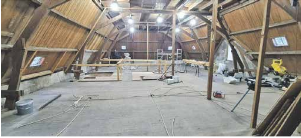
Bovenverdieping voor de verbouwing
